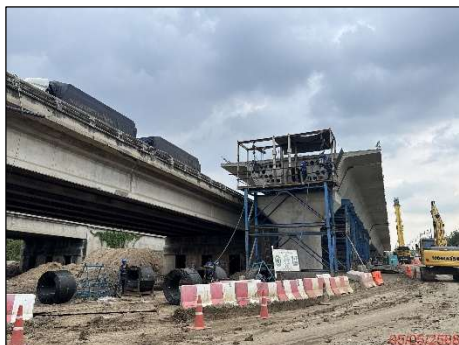
การดึงลวดอัดแรง Segment Box Girder ส่วนที่อยู่บนบก กม.74+400 (ซ้ายทาง)
