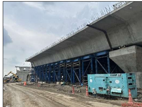
การติดตั้ง Segment Box Girder ส่วนที่อยู่บนบก กม.74+350 (ซ้ายทาง)
